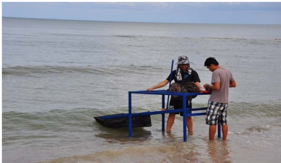
รูปที่ 3.18 การติดตั้งเครื่องผลิตไฟฟ้าจากพลังงานคลื่นทะเล
