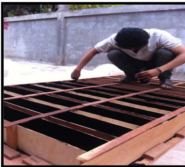
รูปที่ 3.7 แบบหล่อตัวอย่างคานคอนกรีตเสริมเหล็กควบคุม
