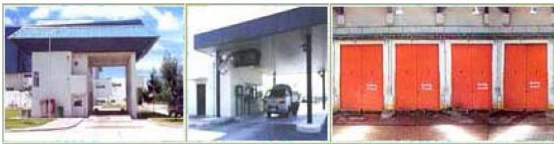
รูปที่ 7.6 อาคารชั่งน้ำหนักและป้อนมูลฝอย [58]
