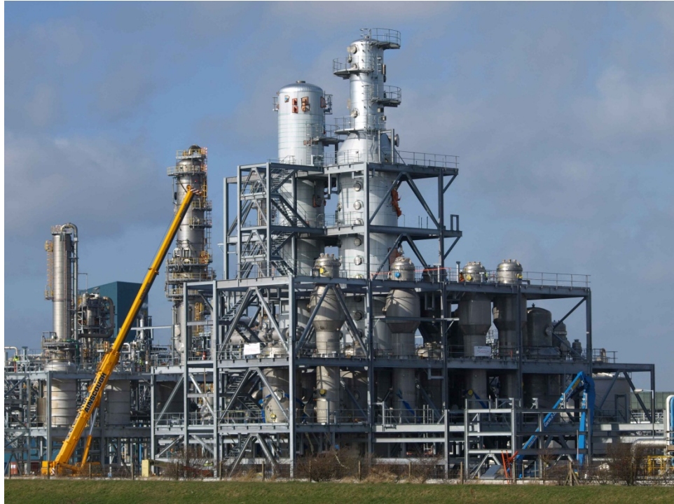
รูปที่ 2.7 โครงสร้างรองรับอุปกรณ์การแยกสาร (Process Structures)
