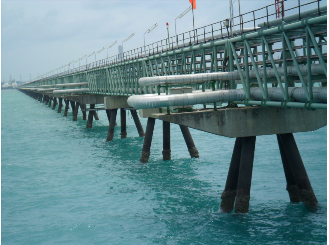
รูปที่ 1.3 ภาพถ่ายของโครงสร้างรองรับท่อส่งปิโตรเลียม (Jetty Bridge)
