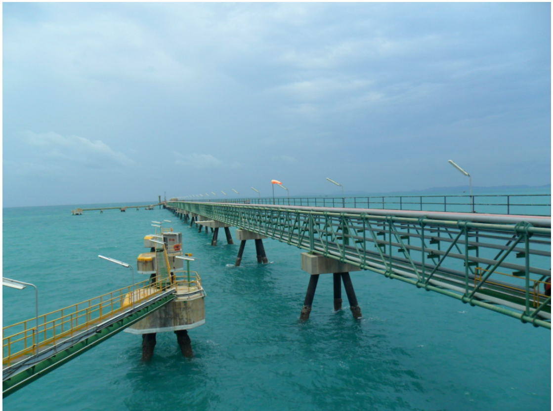
รูปที่ 1.4 ภาพถ่ายของโครงสร้างรองรับท่อส่งปิโตรเลียม (Jetty Bridge)
