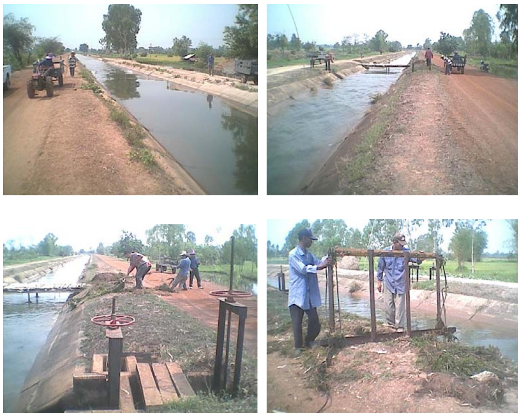
ภาพที่ 4.22 การกำจัดวัชพืช โดยใช้รถไถเล็ก 2 คัน ลากโครงเหล็กตัดผ่านคันคลอง
