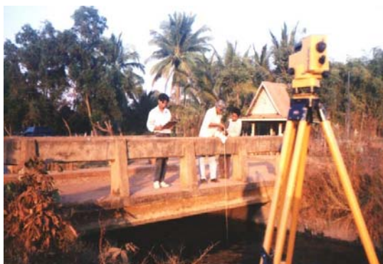
ภาพที่ 4.1 การตรวจวัดระดับผิวน้ำ และวัดกระแสสำหรับคลอง 4R- RMC
