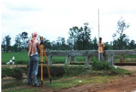
ภาพที่ 3.12 การสำรวจระดับหมุดอ้างอิงชั่วคราวและการวัดหน้าตัดการไหล
