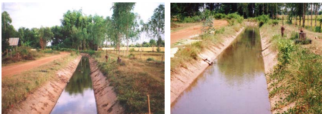
ภาพที่ 3.2 สภาพคลองส่งน้ำ 4L-4R-RMC
