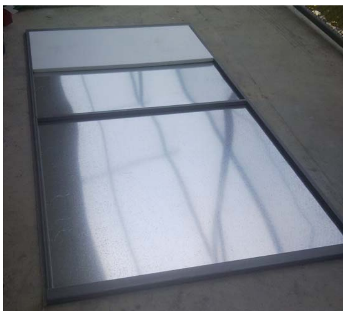
รูปที่ 3.9 แสดงภาพการสร้างฉนวนกันความร้อน
