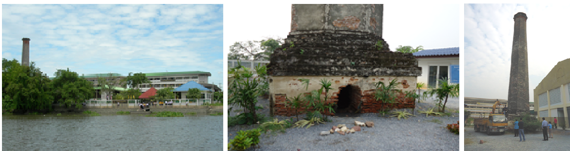
ภาพที่ 4.2 บรรยากาศของโรงเรียนและปล่องเหล็ก ซึ่งอยู่ภายในโรงเรียนบ้านปล่องเหล็ก
