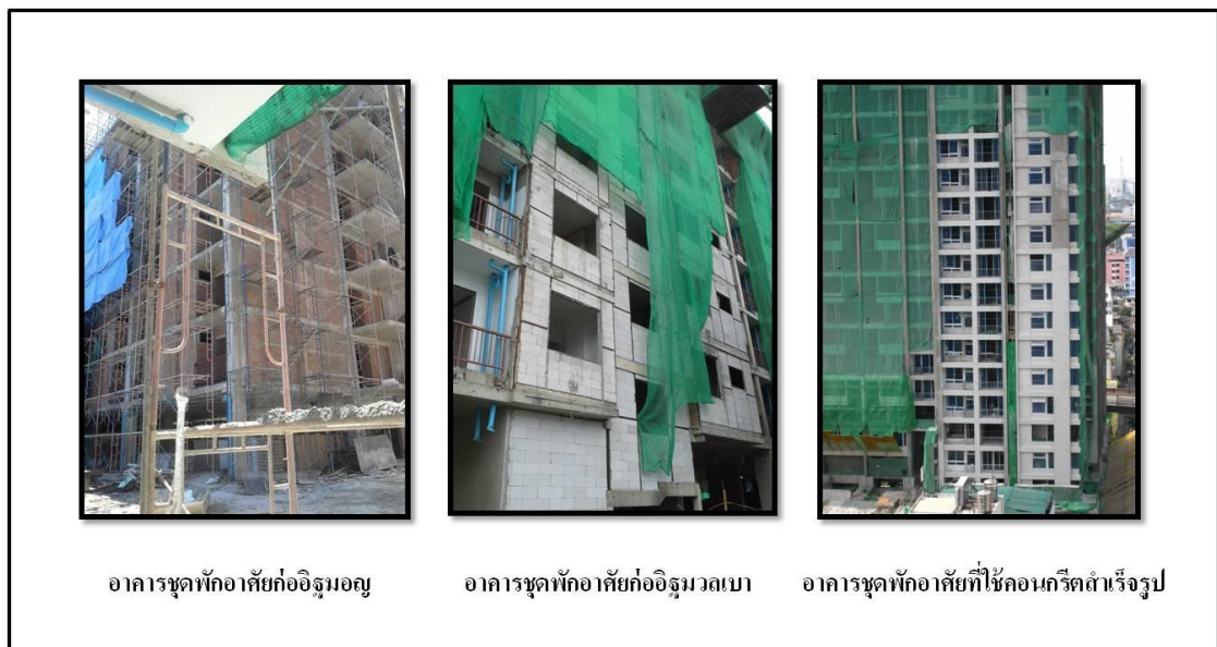
รูปที่ 4.1 ตัวอย่างวัสดุหลักที่ใช้ในการสร้างอาคารชุดพักอาศัย
