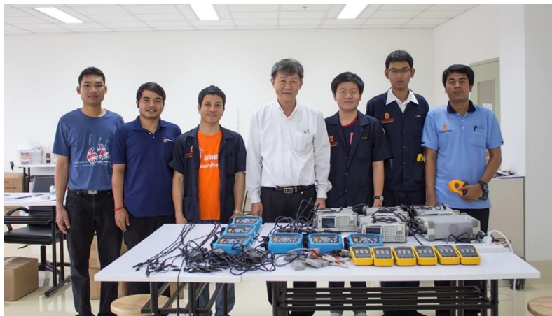
รูปที่ 5.4 แสดงภาควิชาฯ นำนักศึกษาไปตรวจสอบระบบไฟฟ้า ณ มจร. ราชบุรี
