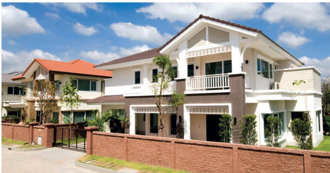
ภาพที่ 5.8 อาคารพักอาศัยประเภทบ้านเดี่ยว 2 ชั้น
