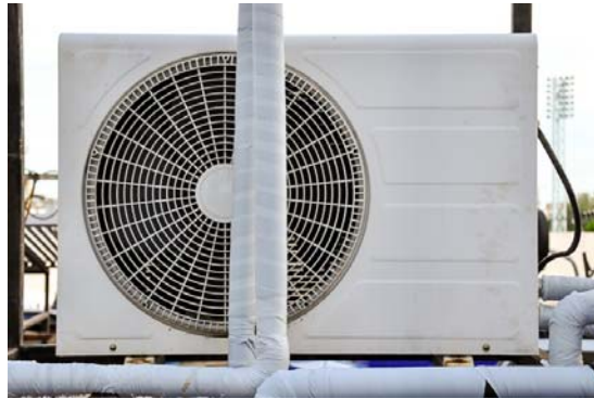
รูปที่ 3.25 เครื่องระบายความร้อนจากน้ำร้อน
