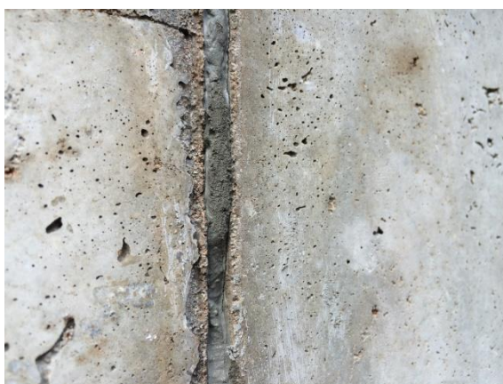
รูปที่ 4.22 รอยต่อของแผ่นผนังไม้เทียมจากต้นมันสำปะหลังผสมซีเมนต์หลังการฉาบอุด
