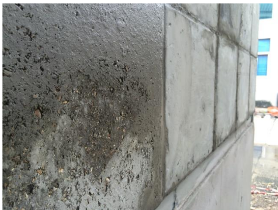
รูปที่ 4.23 แผ่นผนังไม้เทียมจากต้นมันสำปะหลังผสมซีเมนต์ก่อนการฉาบผิว
