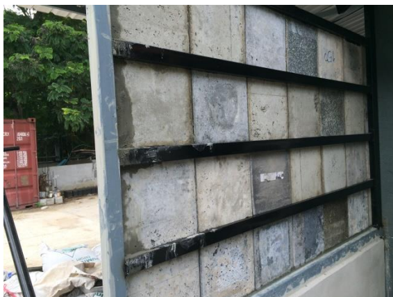
รูปที่ 4.20 รอยต่อของแผ่นผนังไม้เทียมจากต้นมันสำปะหลังผสมซีเมนต์ที่ต้องทำการฉาบอุด
