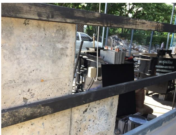
รูปที่ 4.19 โครงคร่าวด้านหลังที่ขันตะปูเกลียวปลายปล่อยลงบนแผ่นผนังไม้เทียมจากต้นมันสำปะหลังผสมซีเมนต์โดยไม่มีการยื่นออกมา
