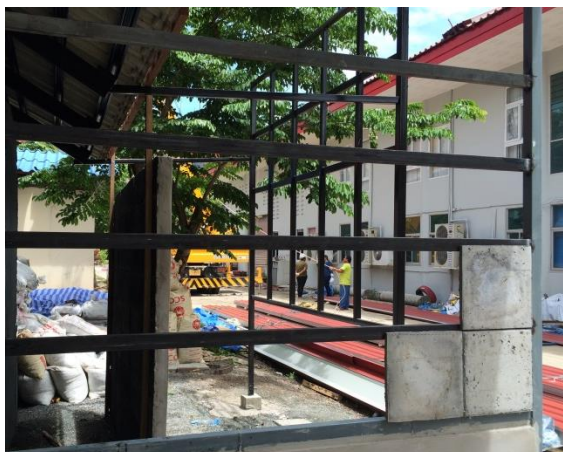
รูปที่ 4.17 การยึดแผ่นผนังไม้เทียมจากต้นมันสำปะหลังผสมซีเมนต์ลงบนโครงคร่าวเหล็ก
