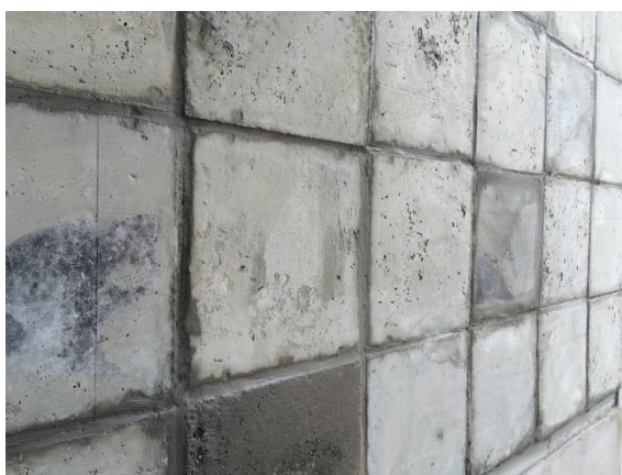
รูปที่ 4.24 แผ่นผนังไม้เทียมจากต้นมันสำปะหลังผสมซีเมนต์หลังการฉาบผิว
