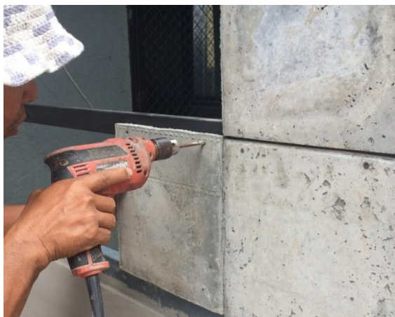
รูปที่ 4.18 การใช้สว่านไฟฟ้าขันยึดตะปูเกลียวปลายปล่อยลงบนแผ่นผนังไม้เทียมจากต้นมันสำปะหลังผสมซีเมนต์ลงบนโครงคร่าวเหล็ก
