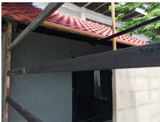
รูปที่ 4.16 โครงคร่าวสำหรับยึดแผ่นผนังไม้เทียมจากต้นมันสำปะหลังผสมซีเมนต์
