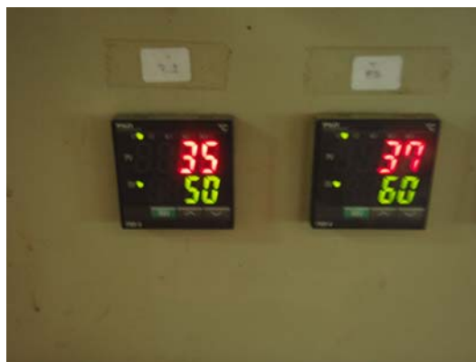
ภาพที่ 4.9.1.6 ลักษณะอุปกรณ์ในชุดตัวควบคุมอุณหภูมิแบบเปิด-ปิด
