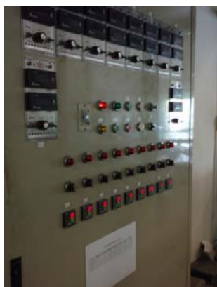
ภาพที่ 4.9.1.6 ลักษณะอุปกรณ์ในชุดตัวควบคุมอุณหภูมิแบบเปิด-ปิด
