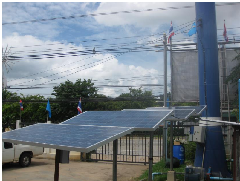
รูปที่ 3.23 ติดตั้งแผงเซลล์แสงอาทิตย์
