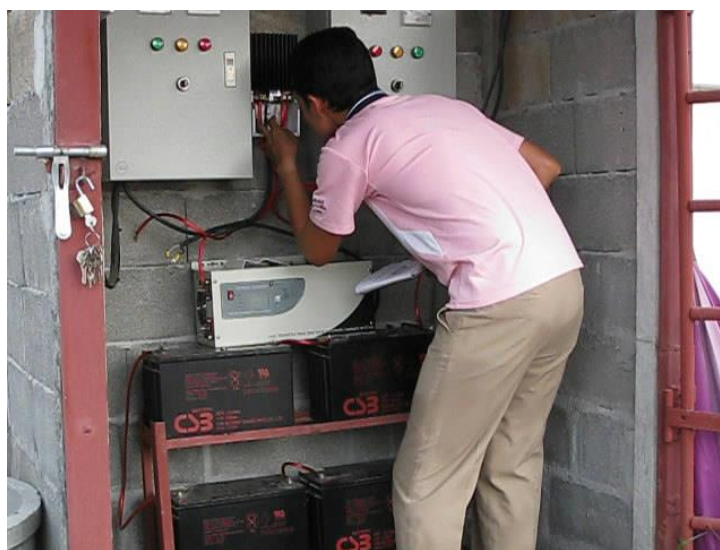
รูปที่ 3.24 การเดินสายไฟเพื่อต่อจากแผงเซลล์แสงอาทิตย์เข้ากับชุดควบคุมการชาร์จ
