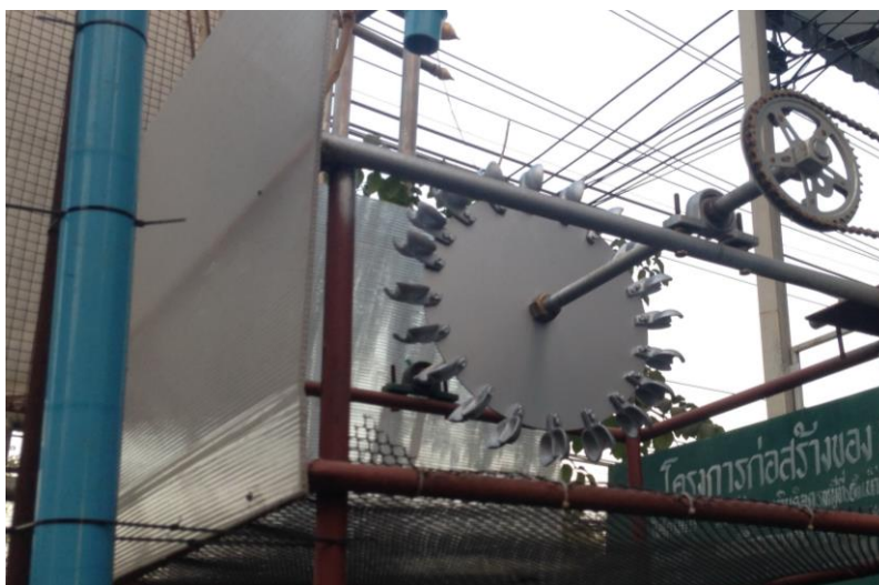
รูปที่ 3.20 ติดตั้งชุดกังหัน
