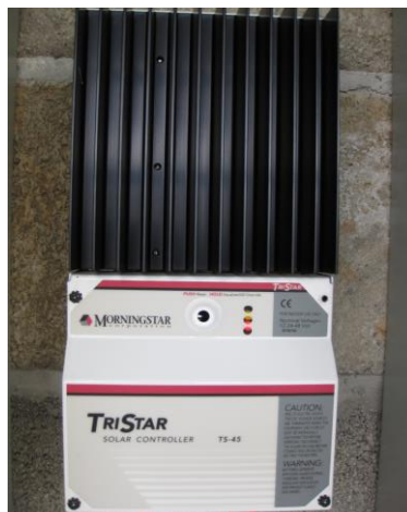
รูปที่ 2.18 Charge controller
