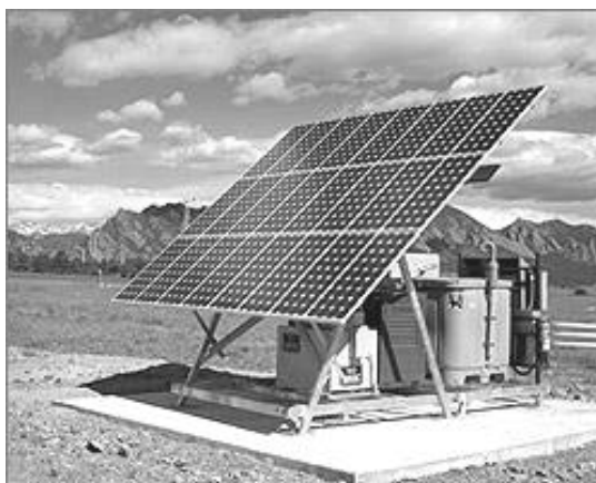
รูปที่ 2.26 ระบบผลิตไฟฟ้าผสมผสานระหว่างเซลล์แสงอาทิตย์กับเครื่องกำเนิดไฟฟ้า [10]
