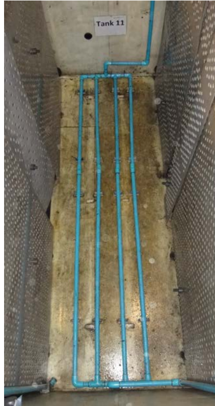
รูป ก.5 ท่อลมระบายความร้อนแบบ 4 เส้น แบ่งเป็น 2 ส่วน
