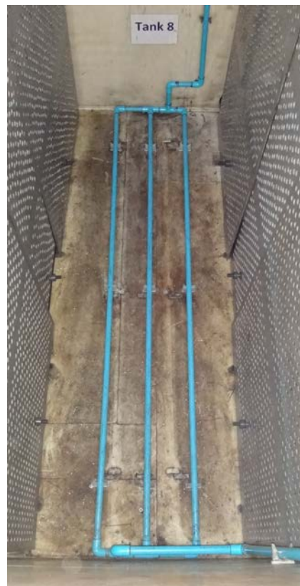
รูป ก.2 ท่อลมระบายความร้อนแบบ 3 เส้น ระยะห่างระหว่างเส้น 25 เซนติเมตร
