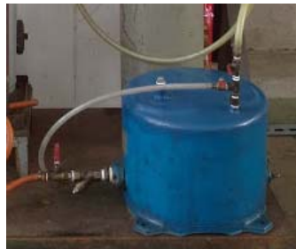
รูปที่ ก.15 ถังน้ำ
