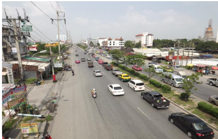
รูปที่ 3.2 ลักษณะทางกายภาพของถนนเทพารักษ์บริเวณใกล้เคียงพื้นที่โครงการ
