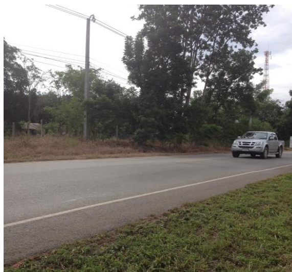
รูปที่ 2.12 ถนนแอสฟัลต์คอนกรีตที่ผสมยางพาราบริเวณหน้าศูนย์วิจัยยาง
