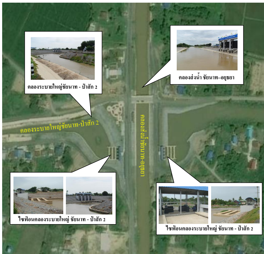
รูปที่ 4.3 สภาพพื้นที่บริเวณโครงสร้างประตูละบายน้ำบางโฉมศรี
