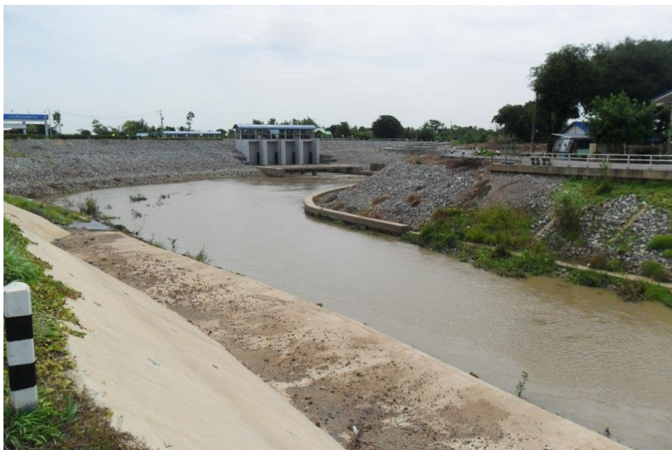
(ข) บริเวณโครงสร้างไซฟอนคลองระบายใหญ่ ชัยนาท - ป่าสัก 2
