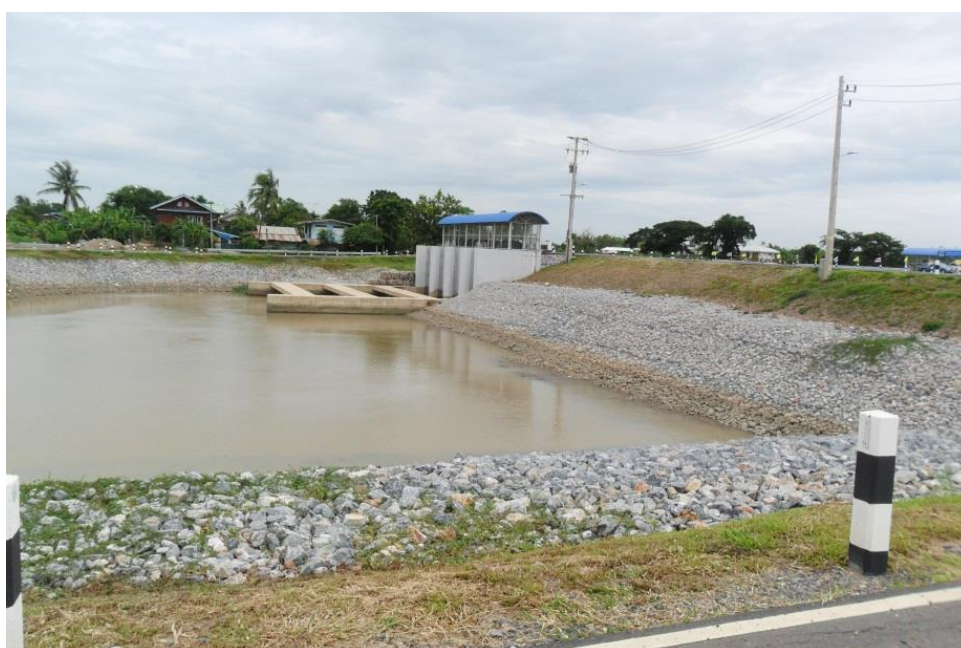
(ก) บริเวณโครงสร้างไซฟอนคลองระบายใหญ่ ชัยนาท - ป่าสัก 2 ในช่วงท่ายน้ำ รูปที่ 3.9 โครงสร้างไซฟอนคลองระบายใหญ่ ชัยนาท - ป่าสัก 2
