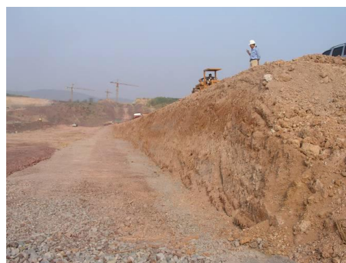
รูปที่ 2.15 การแตกของดินแกนเขื่อนเนื่องจากการทิ้งค้างให้เกิดการระเหยของน้ำ
