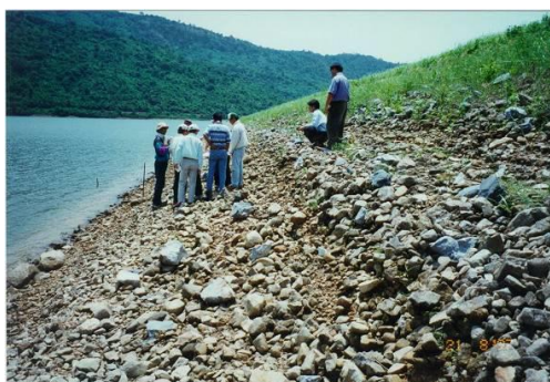
รูปที่ 2.26 การกัดเซาะตัวเขื่อน
