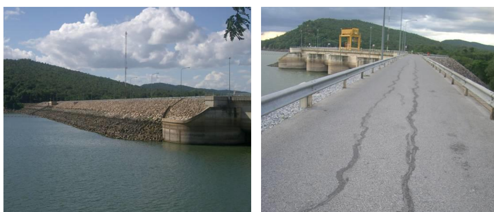
รูปที่ 2.17 การแตกตามยาวของเขื่อนอุบลรัตน์เนื่องจากการเสริมสันเขื่อน
