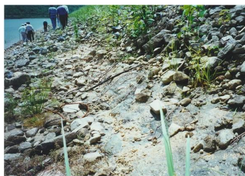
รูปที่ 2.26 การกัดเซาะตัวเขื่อน
