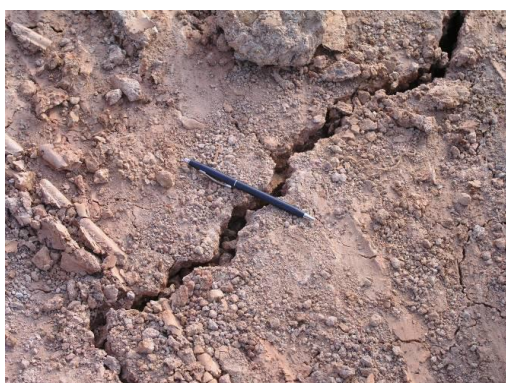
รูปที่ 2.15 การแตกของดินแกนเขื่อนเนื่องจากการทิ้งค้างให้เกิดการระเหยของน้ำ
