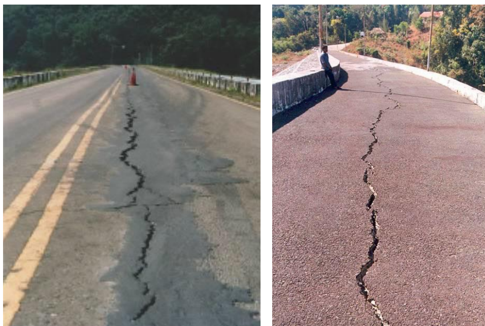
รูปที่ 2.16 รอยแตกขนานแนวสันเขื่อน
