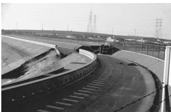
รูปที่ 2.19 การพิบัติเนื่องจากการแตกภายในตัวเขื่อน
