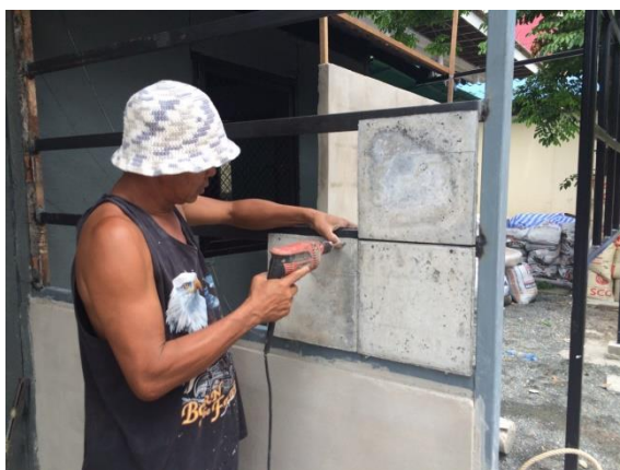
รูปที่ 4.17 การใช้สว่านไฟฟ้าขันตะปูเกลียวปลายป้อยลงในโครงคร่าวเหล็ก เพื่อติดตั้งแผ่นซีเมนต์บอร์ดจากถ้ำกะลามะพร้าว
