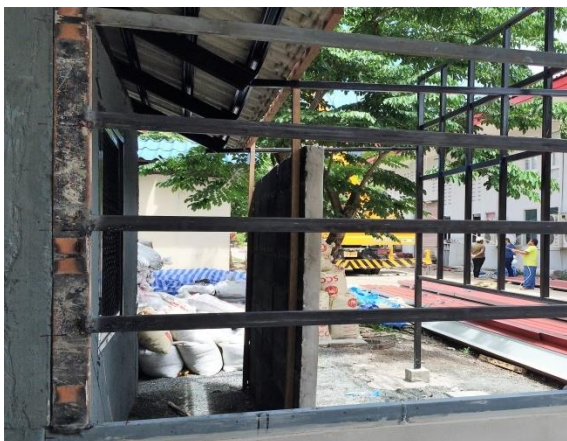
รูปที่ 4.16 โครงคร่าวเหล็กสำหรับติดตั้งแผ่นซีเมนต์บอร์ดจากถ้ำกะลามะพร้าว
