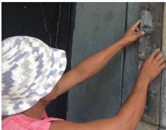
รูปที่ 4.19 การติดตั้งแผ่นซีเมนต์บอร์ดจากถ้ำกะลามะพร้าวที่ผ่านการตัดให้เล็กเพื่อเข้ามุมผนัง
