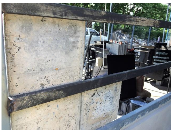
รูปที่ 4.18 ด้านหลังโครงคร่าวเหล็กที่มีการติดตั้งแผ่นซีเมนต์บอร์ดจากถ้ำกะลามะพร้าว
