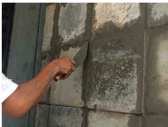
รูปที่ 4.20 การฉาบปิดรอยต่อแผ่นซีเมนต์บอร์ดจากถ้ำกะลามะพร้าวด้วยกาวซีเมนต์
