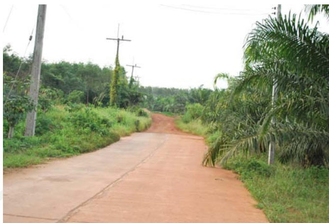
ภาพผนวกที่ ง10 ถนนคอนกรีตเสริมเหล็กในหมู่บ้าน
