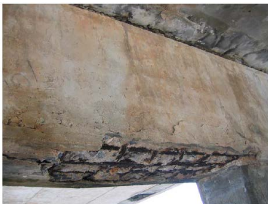
ภาพที่ 17 การหลุดลอกบริเวณคานขวางของสะพาน
