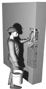
ภาพที่ 26 การซ่อมคอนกรีตที่เสื่อมสภาพและหลุดล่อนในบริเวณแนวตั้งด้วยวิธีซ่อมแซมด้วยมือ
