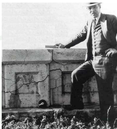
ภาพที่ 1 Stanton และโครงสร้างสะพานคอนกรีตที่พบปฏิกิริยาแอลคาไลกับมวลรวมครั้งแรก
