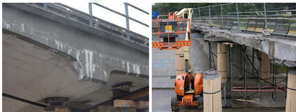
ภาพที่ 10 รอยแตกร้าวและคราบขาวที่พบในสะพาน Schoonhoven ในประเทศเนเธอร์แลนด์ที่พบปัญหาปฏิกิริยาแอลคาไลซิลิกา
