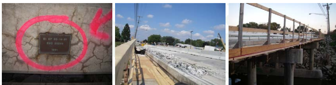
ภาพที่ 11 รอยแตกร้าวที่พบในราวสะพานข้ามแม่น้ำ Red Run สหรัฐอเมริกา จากปัญหาปฏิกิริยาแอลคาไลซิลิกาและการแก้ไข
