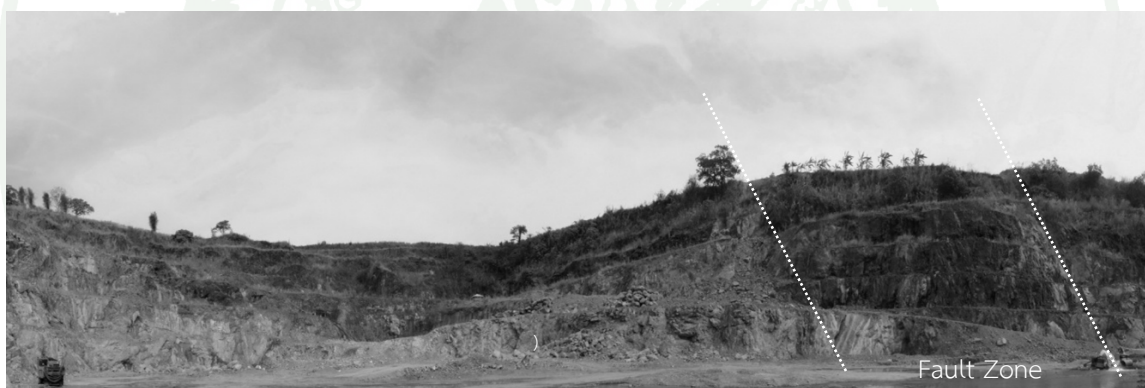
ภาพที่ 38 แนวเขตรอยเลื่อนพาดผ่านแหล่งมวลรวม EGW2
