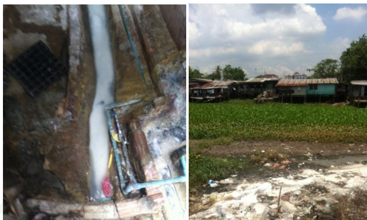
ภาพที่ 39 น้ำเสียจากโรงงานผลิตขมจีนที่ไม่มีการบำบัด และถูกปล่อยสู่ลำคลองสาธารณะ
