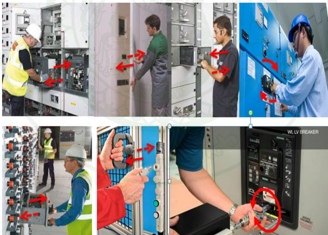
ภาพที่ 69 ลักษณะการทดสอบปฏิบัติงานทางกลของตู้ไฟฟ้า
