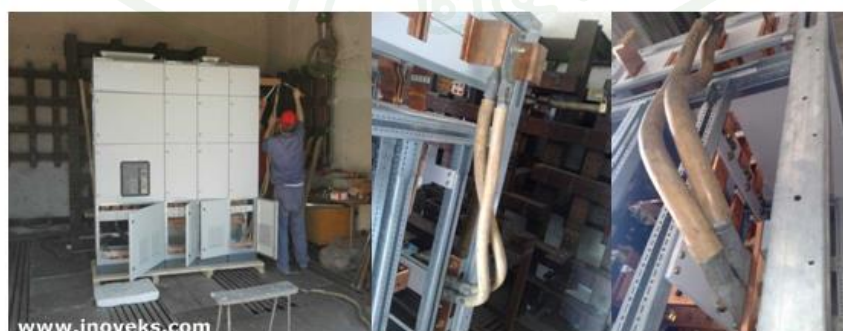
ภาพที่ 66 การทดสอบลัดวงจรที่วงจรป้องกัน
