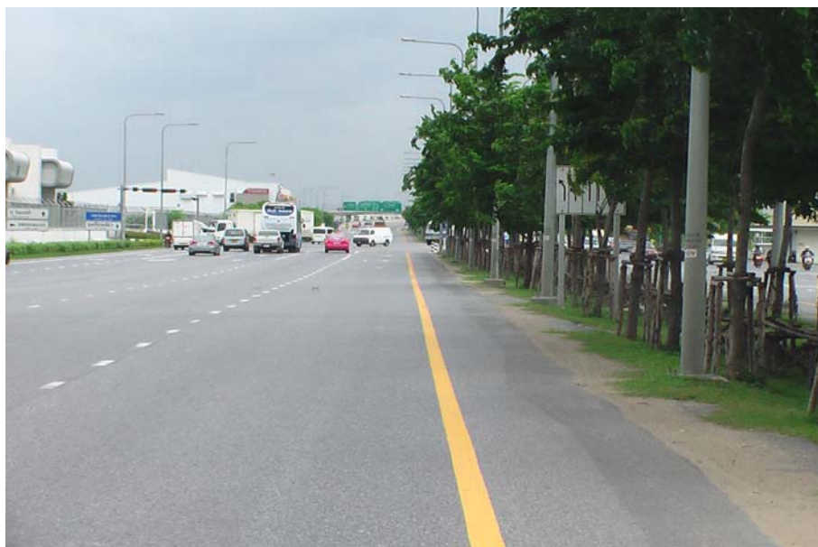
ภาพที่ 4.10 รถเลี้ยวตัดกระแสรถทางตรง , เส้นจราจรลบเลือนและป้ายจราจรบดบัง
