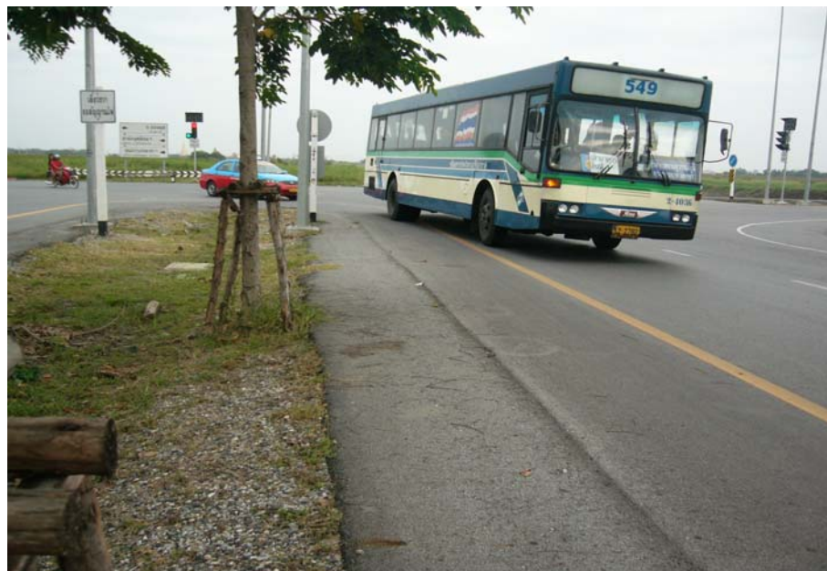
ภาพที่ 4.7 ภูมิทัศน์บดบังป้ายแนะนำ และวงเลี้ยวไม่เหมาะสม บนสามแยกถนน
