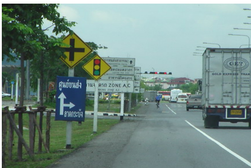
ภาพที่ 4.8 แสดงการตัดกระแส และป้ายบอกเส้นทางสับสน บนถนนสุวรรณภูมิ สาย 2
