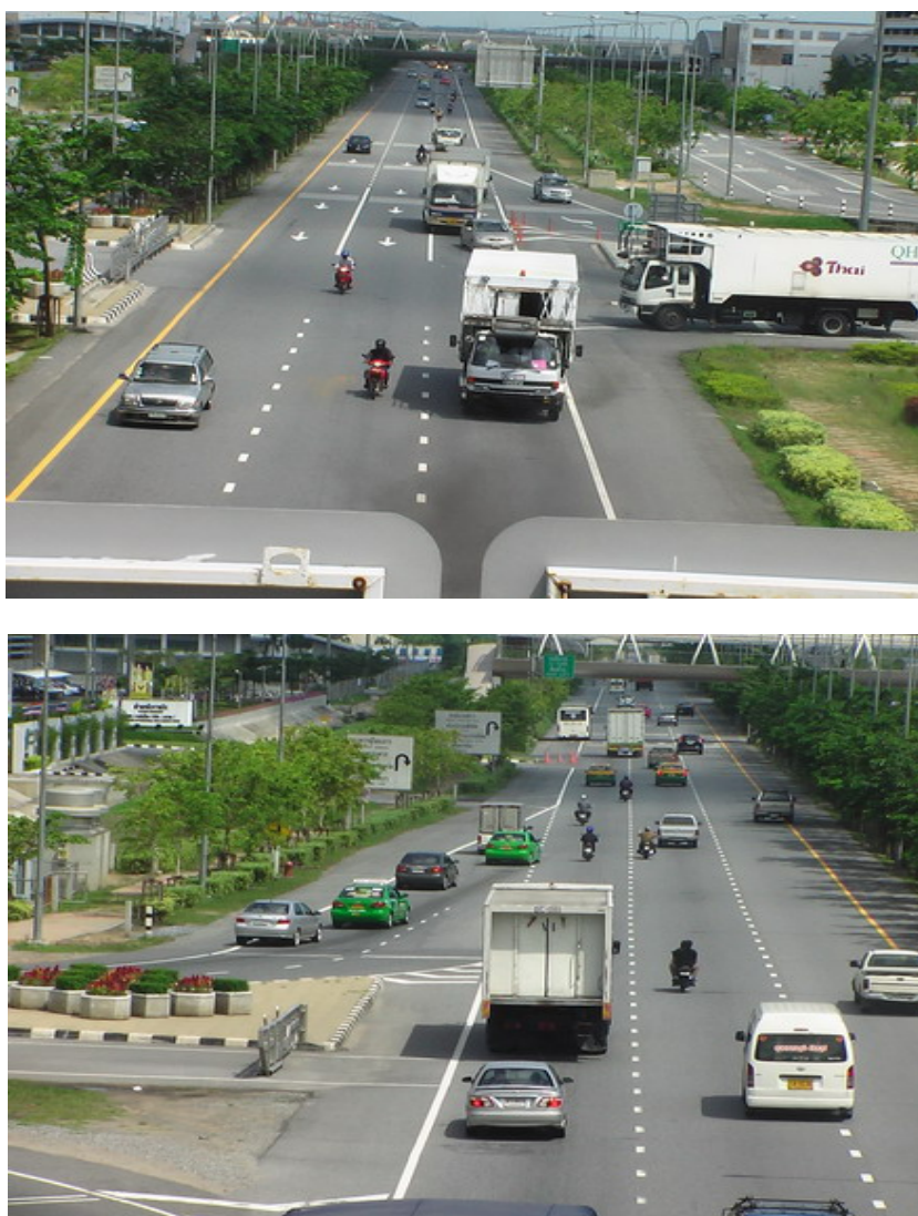
ภาพที่ 4.9 รถที่เลี้ยวตัดกระแสบรรจบทางตรง และระยะ MERGING ไม่เพียงพอ
