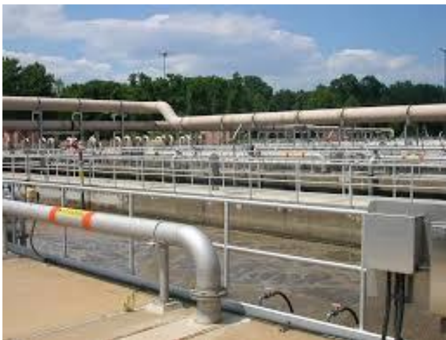
รูปที่ 4.16 การติดตั้งท่อลำเลียงน้ำเสีย [43]
