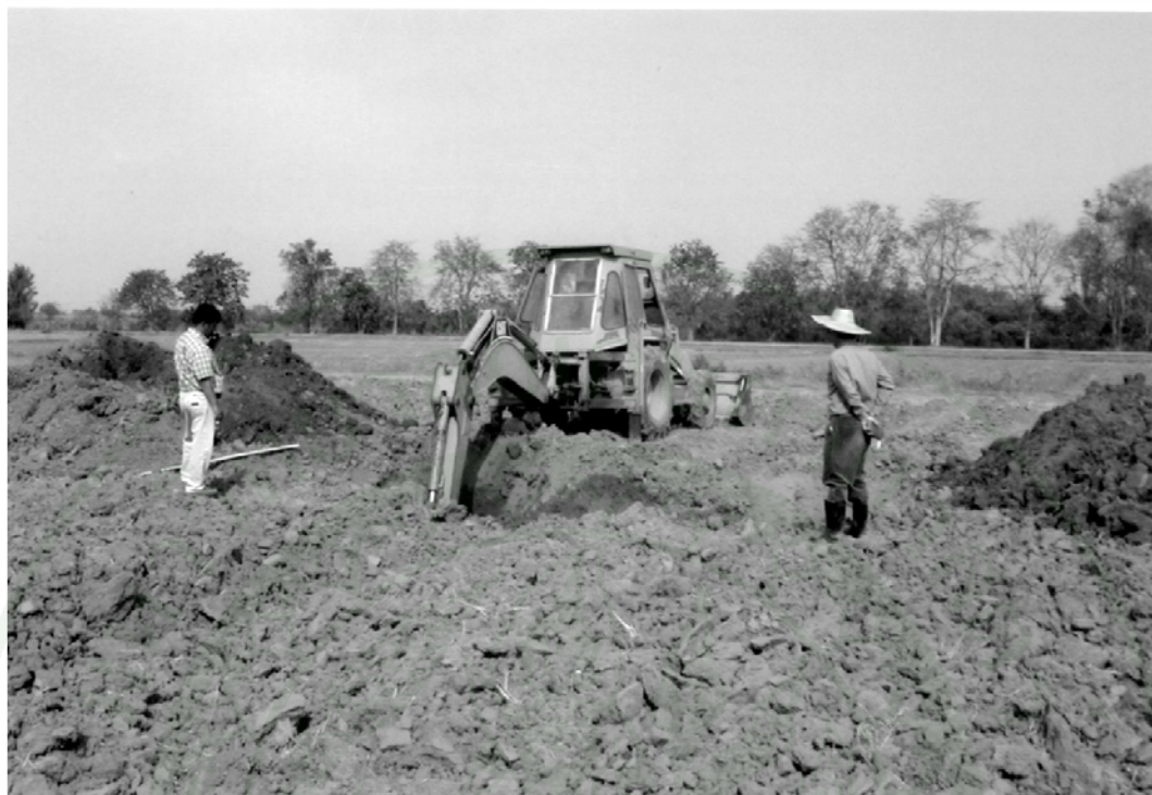
ภาพผนวกที่ 2 เตรียมพื้นที่สำหรับวางถังวัดการใช้น้ำของพืช
