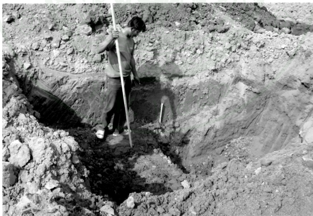
ภาพผนวกที่ 3 การวัดระดับสำหรับวางถังวัดการใช้น้ำของพืช
