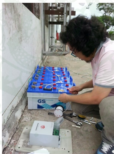
ภาพที่ 28 การต่อแบตเตอรี่และวงจรควบคุม
