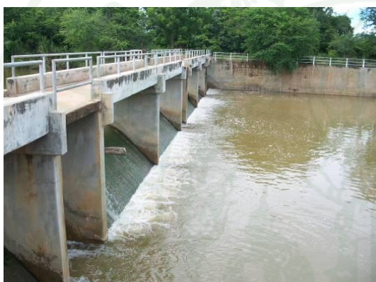
ฝายหนองไม้แก่น
