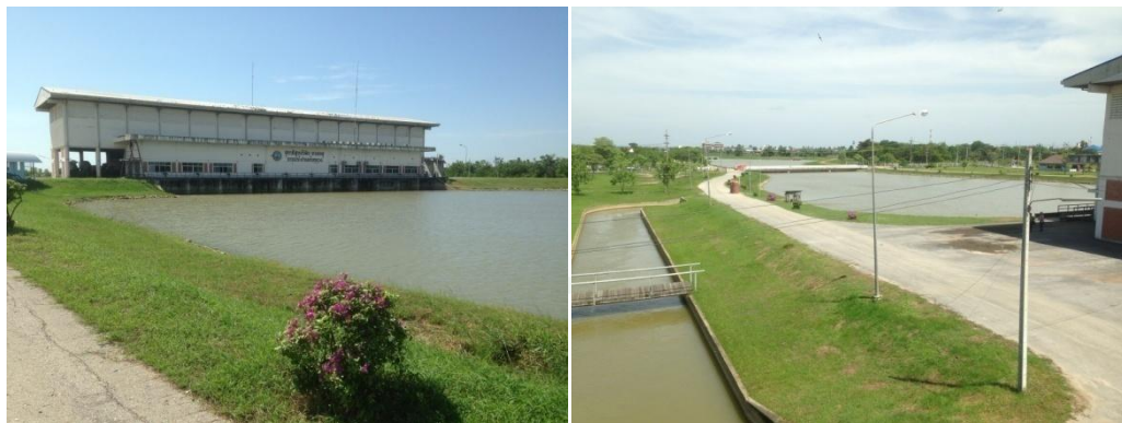
ก) สถานีสูบน้ำ และคลอง bypass
