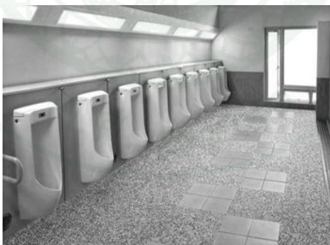
ภาพที่ 8 คอนกรีตพูนสำหรับดูดซับความชื้น
