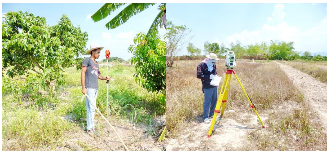
ภาพที่ 4.3 การสำรวจวัดหลักหมุดโดนดินด้วยกล้อง Total Station
