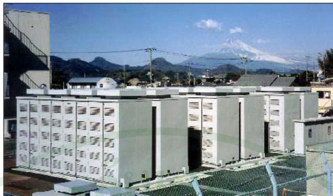
ภาพที่ 13 ชุดเก็บพลังงานโซเดียมซัลเฟอร์ขนาด 6 เมกกะวัตต์ 8 ชั่วโมงที่ติดตั้ง ณ กรุงโตเกียว ญี่ปุ่น
