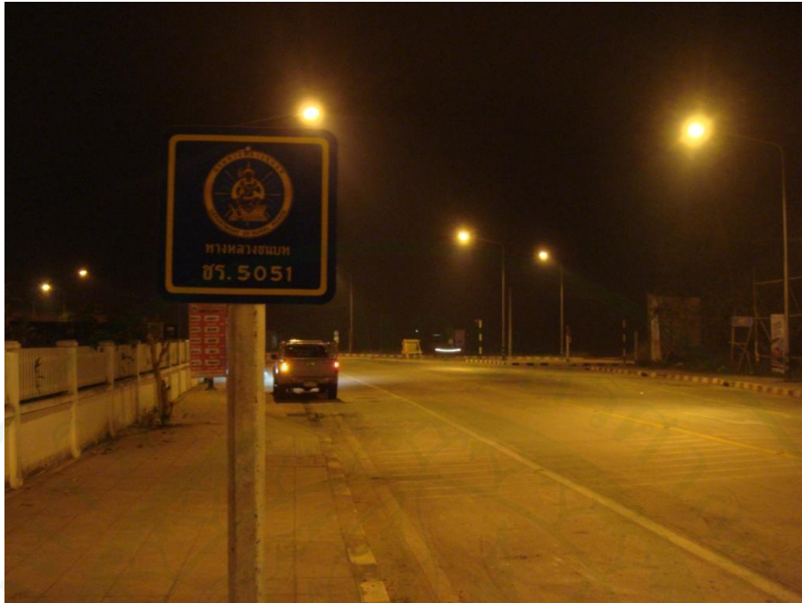
ภาพผนวกที่ 21 การลงสำรวจพื้นที่จริง (Field Survey) ณ จังหวัดเชียงราย สายทาง ชร.5051 (1)
