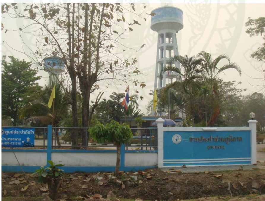
ภาพผนวกที่ 16 การลงสำรวจพื้นที่จริง (Field Survey) ณ จังหวัดเชียงราย สายทาง ชร.1056 (2)
