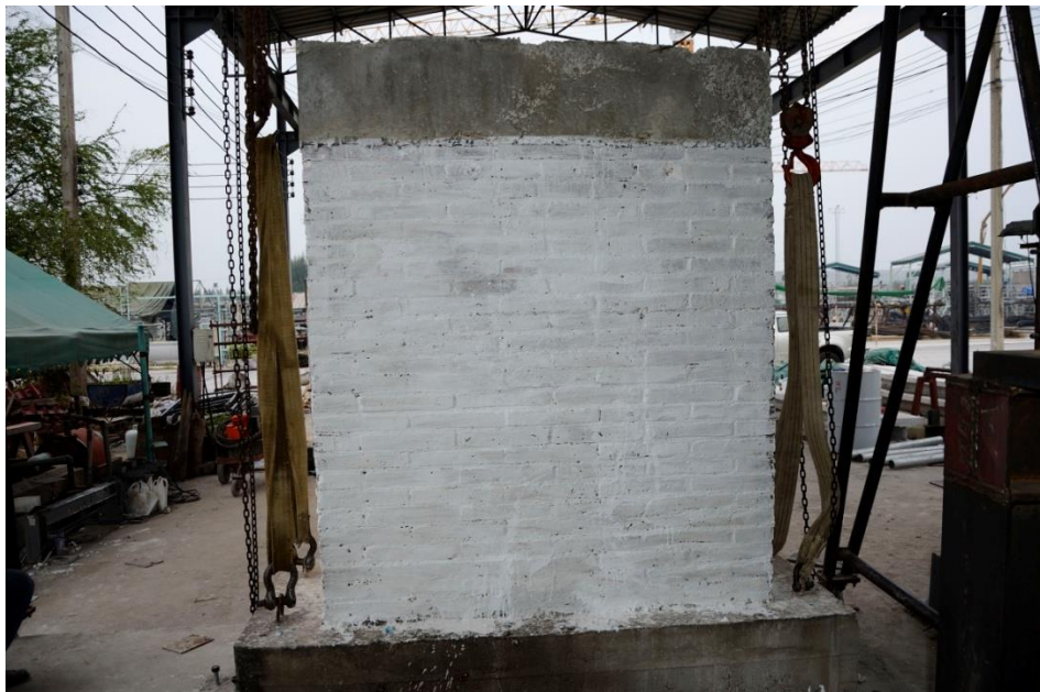
รูปผนวกที่ ข15 ติดตั้งอุปกรณ์เตรียมการทดสอบผนัง AMW 01
