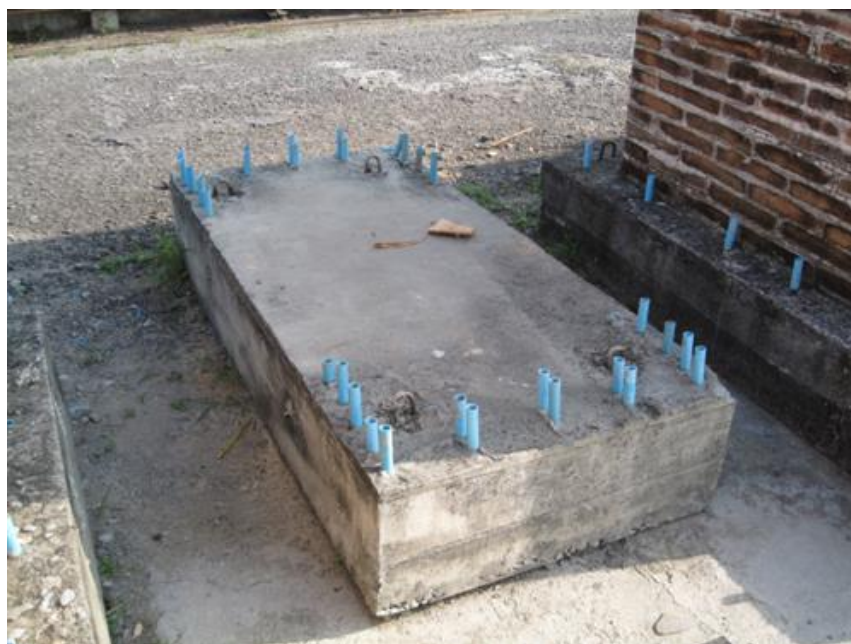
รูปผนวกที่ ๗7 ผนังอิฐก่อโบราณตัวอย่างก่ออยู่บนฐานรากคอนกรีตเสริมเหล็ก ขนาด 0.7x2.4x0.30 m.
