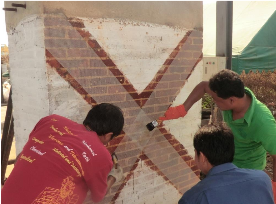
รูปผนวกที่ ข11 ติดตั้งเส้นใยไฟเบอร์ (ต่อ)
