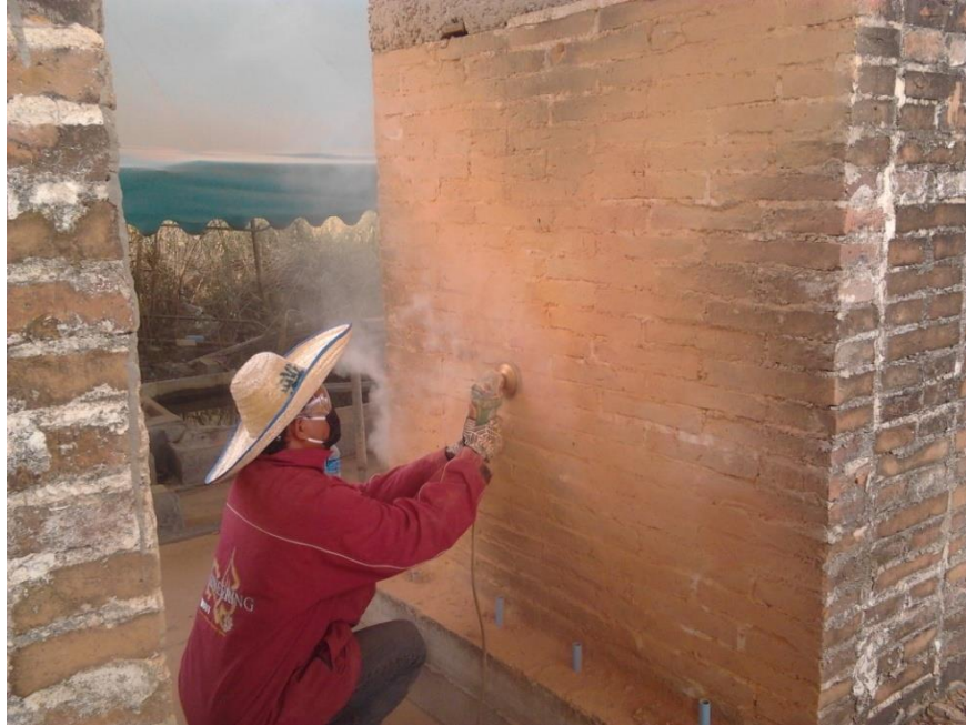
รูปผนวกที่ ข11 ติดตั้งเส้นใยไฟเบอร์
