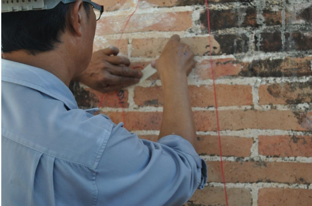
รูปผนวกที่ ข13 ติดตั้ง electric strain gages
