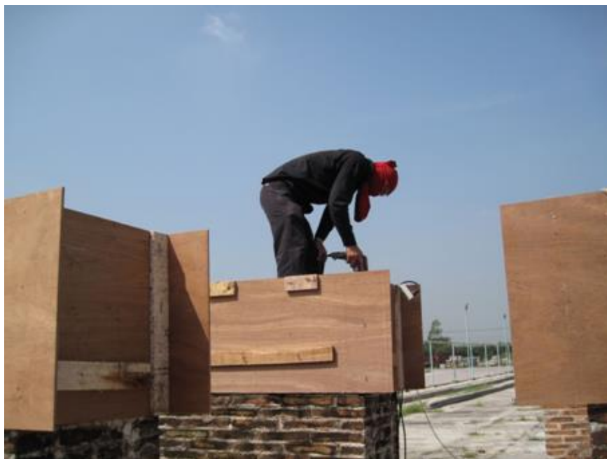
รูปผนวกที่ ข8 เทคนิคทับหลังคอนกรีตเสริมเหล็ก
