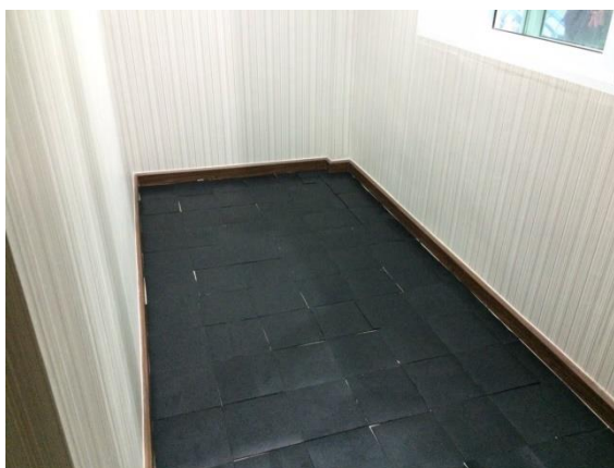
รูปที่ 4.26 ลักษณะการติดตั้งแผ่นกระเบื้องยางพาราผสมพลาสติกอีวีเอที่อัตราส่วน 10 ฟุตเอชอาร์
