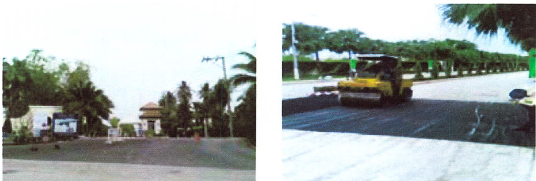
รูปที่ 5.42 แสดงรูปด้านหน้าโครงการและด้านหลังโครงการ
