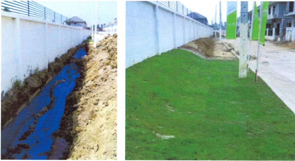
รูปที่ 5.47 แสดงรูปรั้วโครงการที่ติดสวนหรือมีพื้นที่ภายในแคบ
