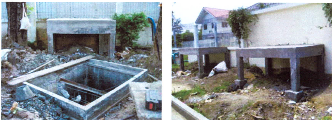
รูปที่ 5.54 แสดงรูปแทนที่จะติดตั้งปั้มน้ำถาวร
