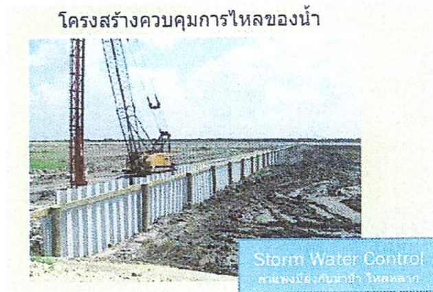
รูปที่ 5.36 กำแพงป้องกันน้ำ (Stormwater Control)
