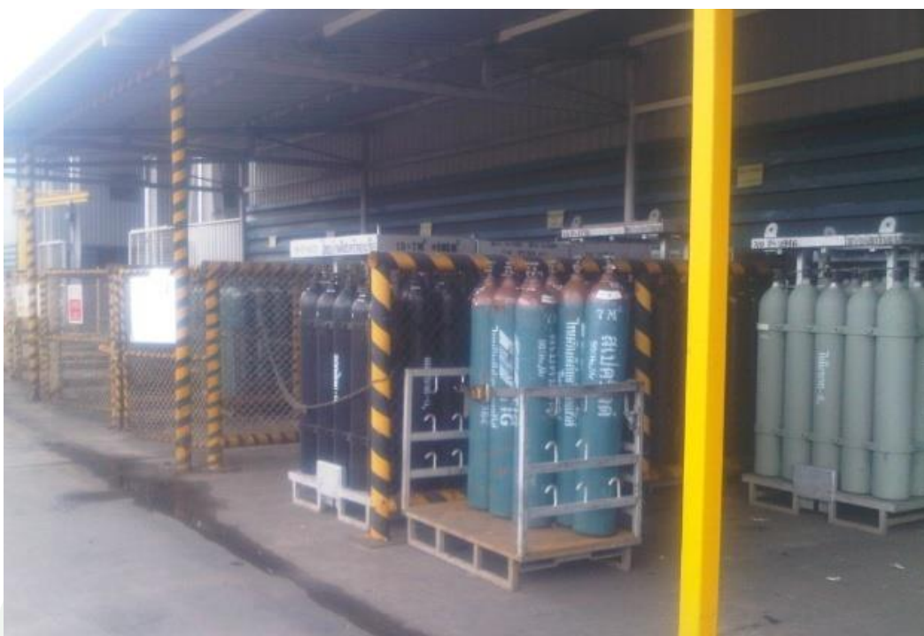
ภาพผนวกที่ ค1 แก๊ซออกซิเจน( O_2 ) ที่ใช้สำหรับกระบวนการตัด
