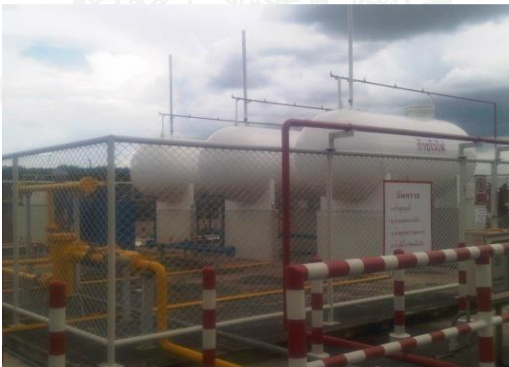
ภาพผนวกที่ ค6 แก๊สแอลพีจี (LPG) ใช้สำหรับกระบวนการอบคลายเคียวและอบชุบแข็ง
