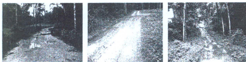
สภาพถนนดินลูกรัง
