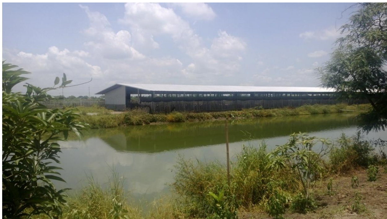
ภาพที่ 3 ลักษณะการเลี้ยงเป็ดที่มีพื้นที่เลี้ยงอยู่ใกล้บริเวณที่ทำการเพาะปลูกข้าว
