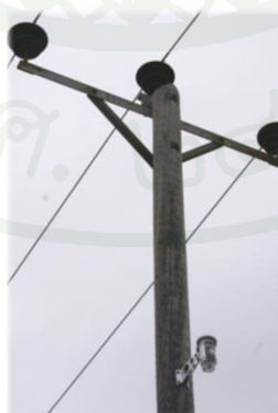
ภาพที่ 9 อุปกรณ์ซึ่งบอกความผิดปกติชนิดติดตั้งที่เสาไฟฟ้าของระบบจำหน่ายเหนือดิน
