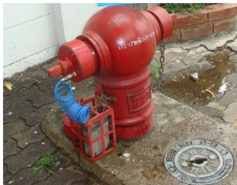
ภาพที่ 15 ตัวอย่างการติดตั้งอุปกรณ์วัดแรงดันบนหัวดับเพลิง
