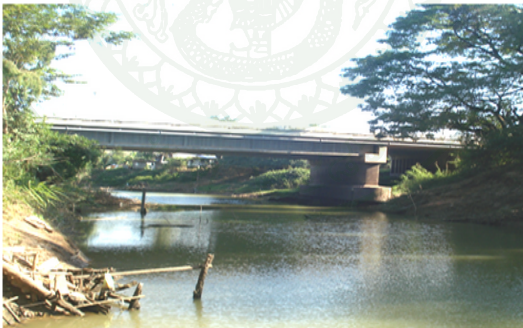
ภาพผนวกที่ ก4 สภาพบริเวณสถานีวัดน้ำท่า E.23 แม่น้ำชี อำเภอเมือง จังหวัดชัยภูมิ
